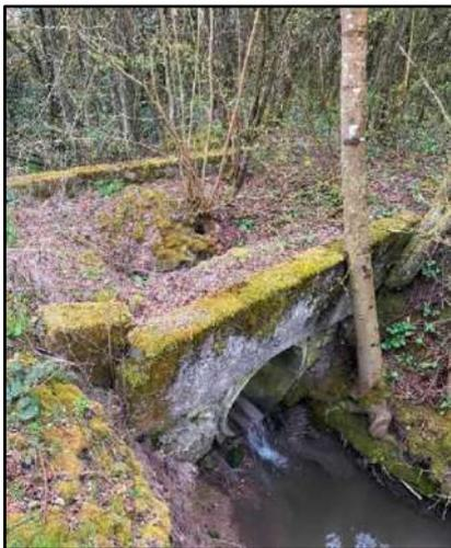
Ouvrage avec une buse à supprimer et une chute de 20 cm à supprimer.
